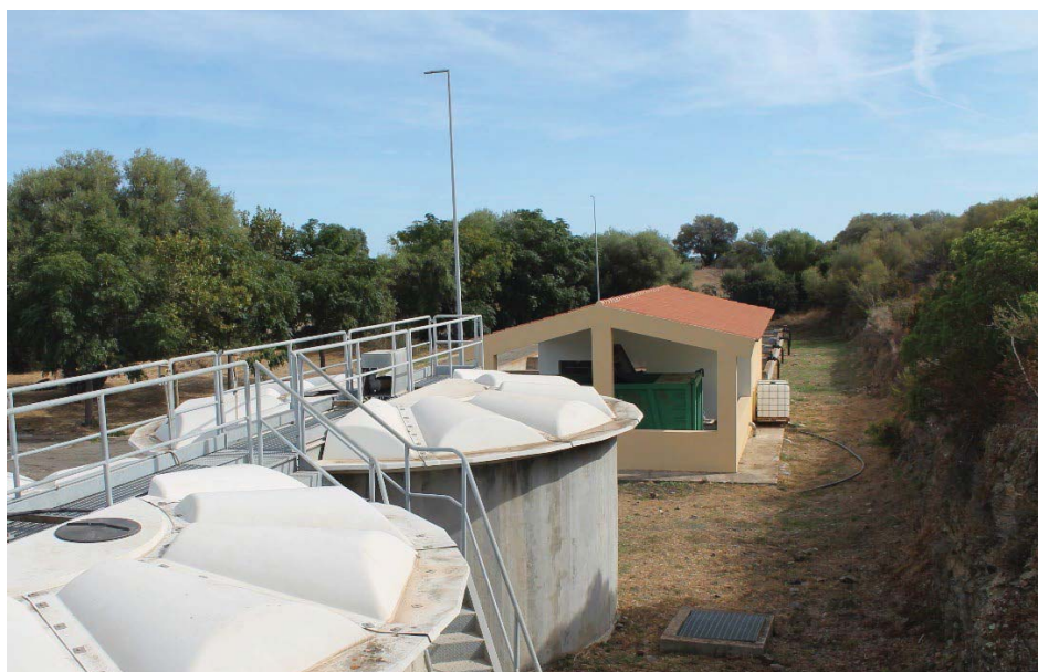
Figura 5 Foto relativa all'esterno del locale disidratazione meccanica fanghi. Si evidenzia la posizione parzialmente incassata rispetto al piano campagna circostante e la presenza di intensa vegetazione sia interna all'impinto che a ridosso della recinzione. Si evidenzia come entrambe le situazioni tendono a mitigare fortemente la trasmissione dei rumori prodotti dai macchinari verso l'esterno.
